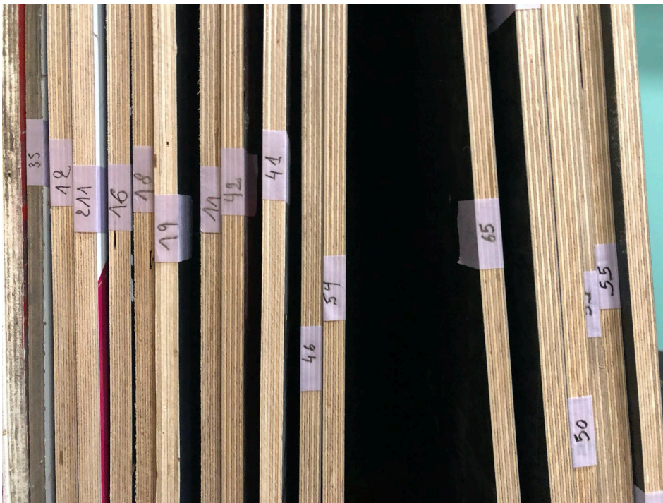
Marquage des panneaux numérotés en fonction de leur position sur le chantier effectué. © QUIPROQUO
