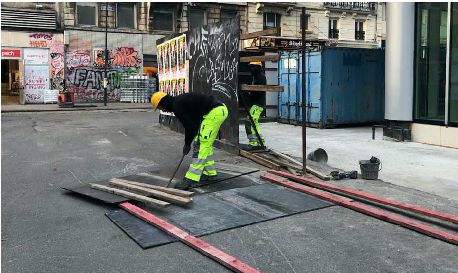
Démontage de la palissade du BruCity par l'entreprise COLAS mandatée par la Ville de Bruxelles. © QUIPROQUO
